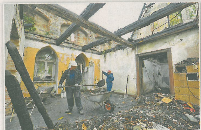
Die Bauarbeiten am Brauhaus in Himmelpfort haben begonnen.
